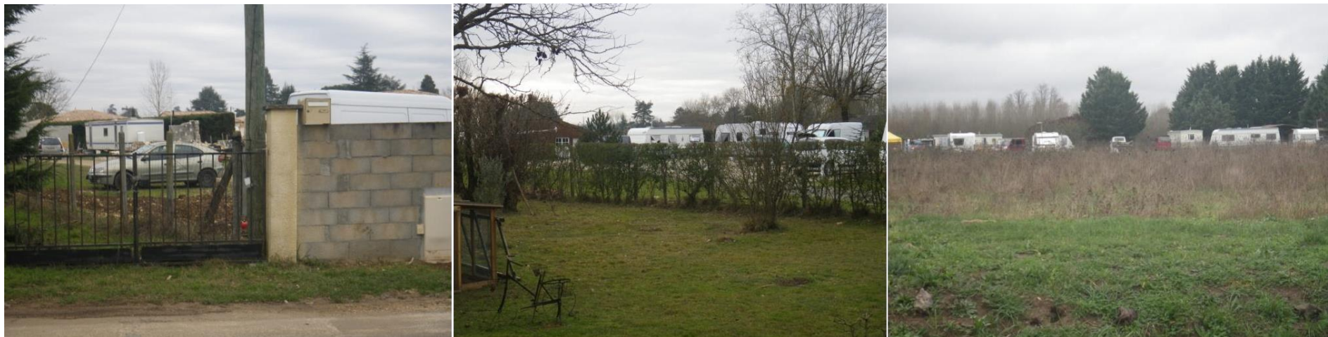
Lamonzie-Saint- Martin : surpopulation, absence de réseaux d'alimentation et d'évacuation. Actuellement de nombreuses constructions continuent d'être édifiées.
